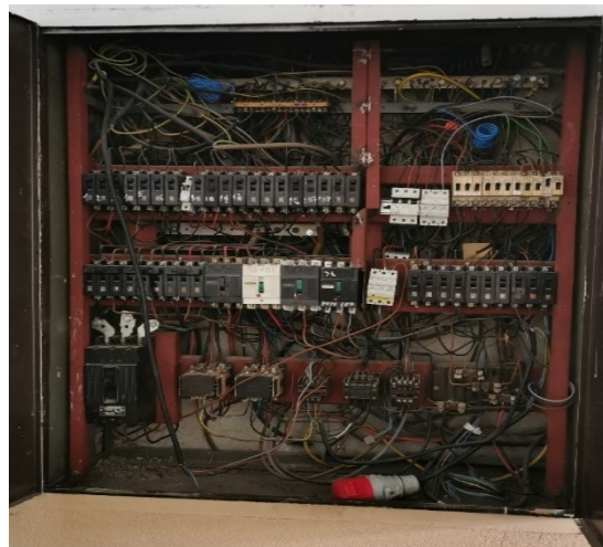
Rozvodná skriňa pred a po rekonštrukcii
